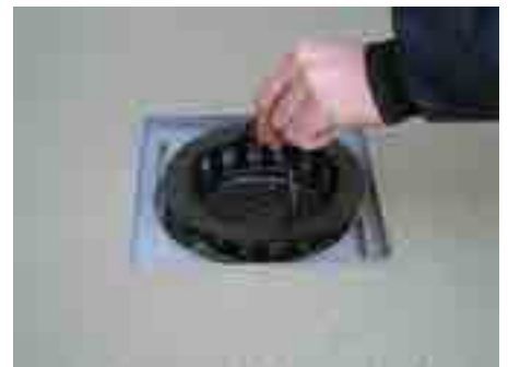
9. Einlaufrost abnehmen und Sandfang in den Ablauf einsetzen
